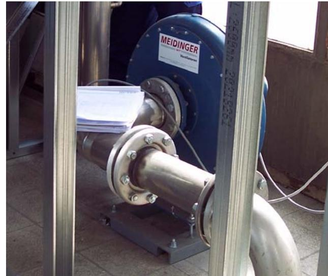
Fachmännisch verbaute Kompensatoren an einem Verdichter (links)
