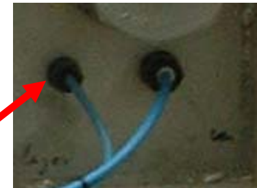
Durchführungen durch die Fermenterwand
