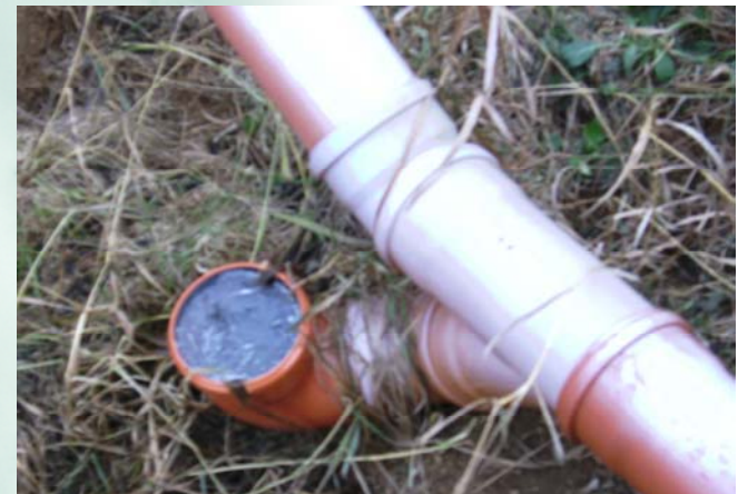
Abgasleitung (re), Gasleitungen (oben), Kühlung BHKW
