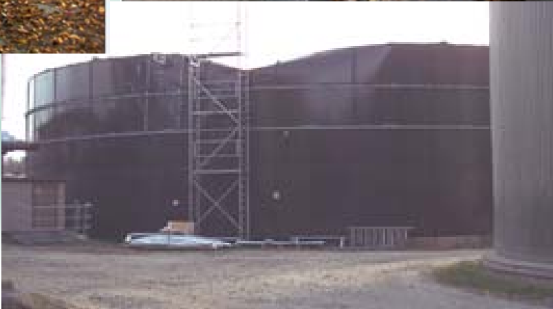
Dachlasten – Doppelmembranhauben, Ablagerungen in Ü / U und die möglichen Folgen
