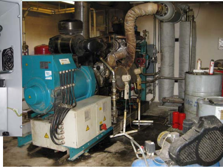
Abgasleitung (re), Gasleitungen (oben), Kühlung BHKW
