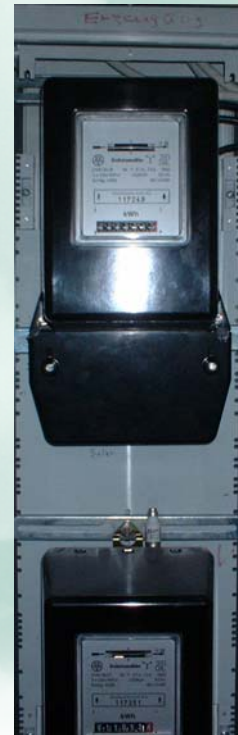
Verrechnungsmessung, erst nach EEG „einspeisen“ und dann den Eigenbedarf mit einem 2. Zähler decken
