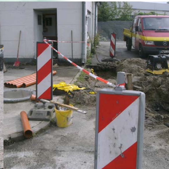
Abb.6 Baustelle auf einer Altablagerung in einem Gewerbegebiet [DAS-IB GmbH, 2009]
