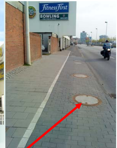
Abb. 14 Schächte für Revisionsöffnungen Absaugung
