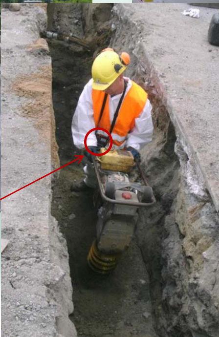
Abb.7 Verdichtungsarbeiten im Leitungsgraben auf bzw. In einer Altablagerung [DAS-IB GmbH, 2009]
