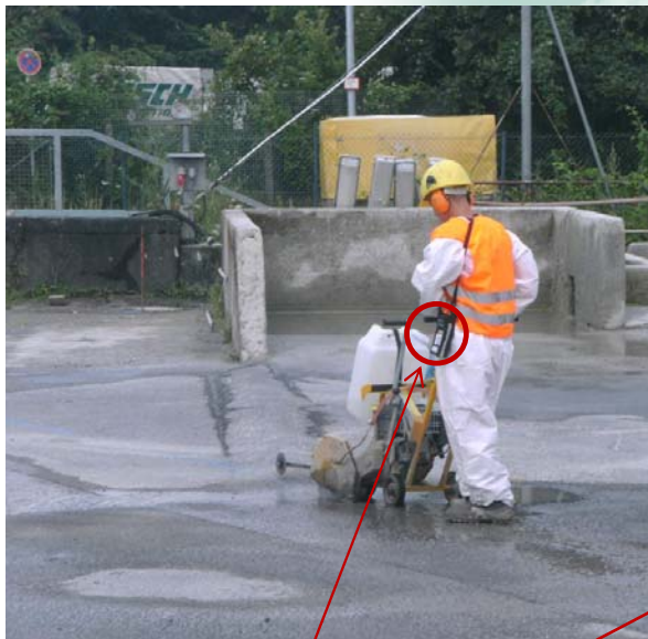
Abb.5 Schneidarbeiten an einer Betonoberfläche auf einer Altablagerung [DAS-IB GmbH, 2009]
