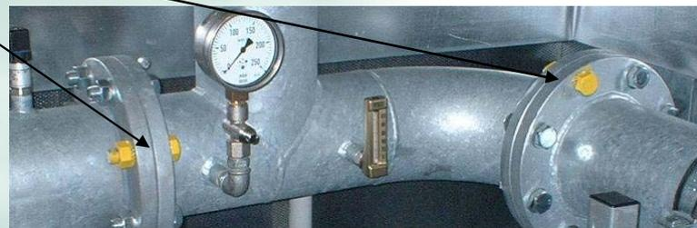
**VDE – Prüfung nach BGV A3 (vorm. VBG 4): UVV Elektrische Anlagen und Betriebsmittel (Stand 2009) – Ein Potentialausgleich der gesamten Anlage ist notwendig !!**
