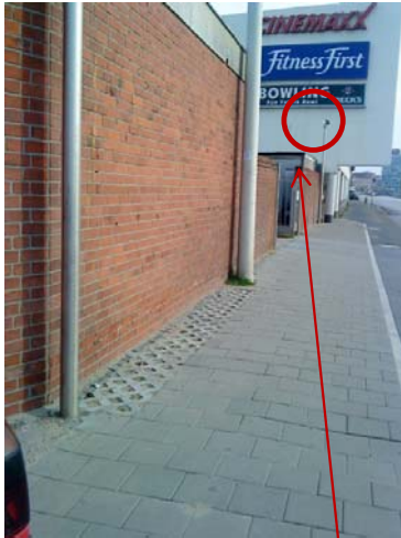
Abb.12 Entlüftungssteine und Entlüfter auf einer auf einer Altablagerung [DAS-IB GmbH, 2010]
