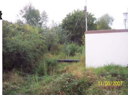
Abb. 6 Gassammelstation mit Wetterstation [DAS-IB GmbH, 2007]
