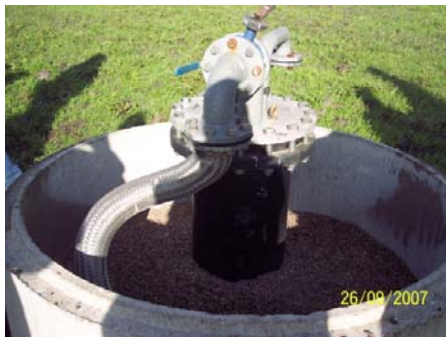
Abb.5 Brunnenkopf mit schräg eingebauter Klappe [DAS-IB GmbH, 2007]
