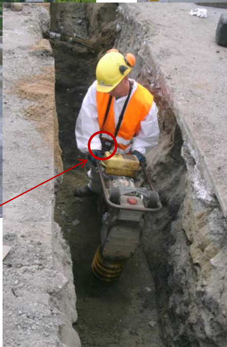
Abb.10 Verdichtungsarbeiten im Leitungsgraben auf bzw. In einer Altablagerung [DAS-IB GmbH, 2009]
