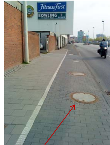
Abb. 14 Schächte für Revisionsöffnungen Absaugung
