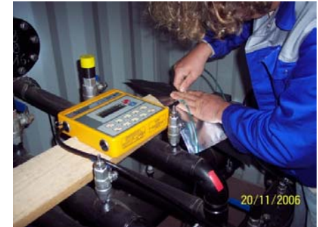
Abb.3 Messung in der Gassammelstation [DAS-IB GmbH, 2009]
