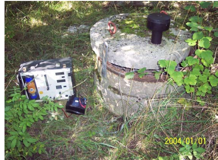
Abb.16 Gaspegelmessung einer Altanlage [DAS-IB GmbH, 2010]
