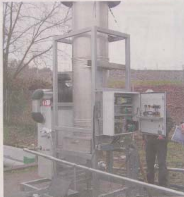
In dieser neuen Anlage wird das Wörther Deponiegas umweltfreundlich verbrannt.
