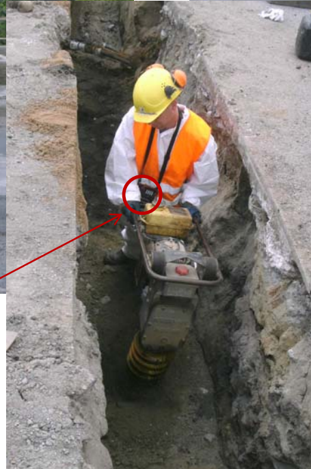
Abb.7 Verdichtungsarbeiten im Leitungsgraben aufzwb. In einer Altanlage [DAS-IB GmbH, 2009]
