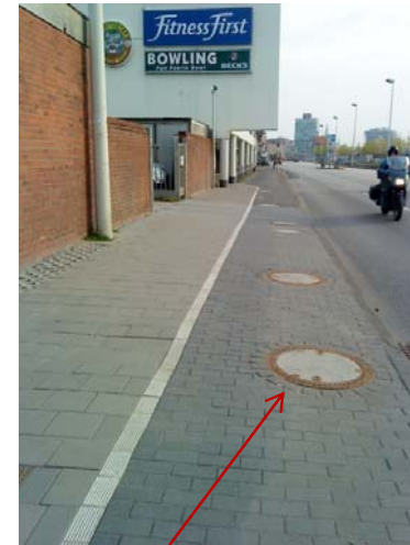
Abb. 14 Schächte für Revisionsöffnungen Absaugung
