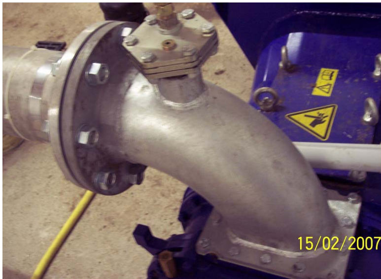
Übergang Edelstahl / Stahl verz. / Stahl lackiert
