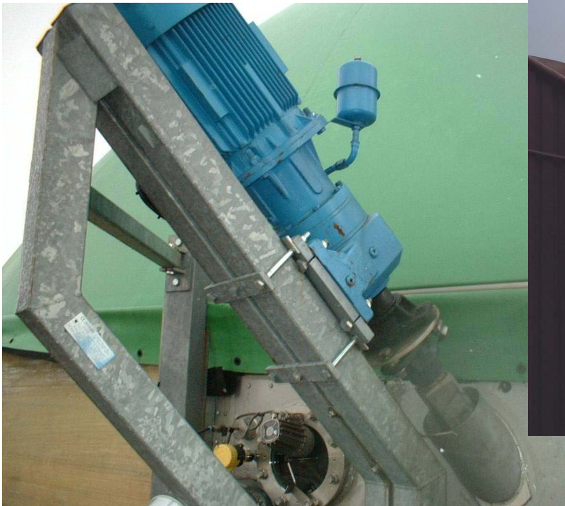
Gegen Schwingungen gesichertes Rührwerk
