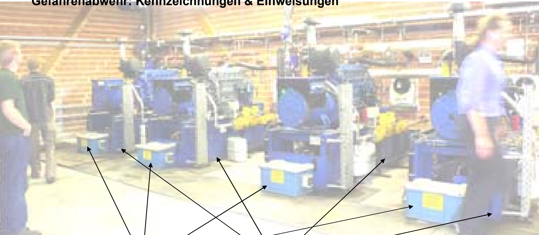
BHKW mit Säurebatterien und Ölauffangwannen unter den Motoren - Kennzeichnung
