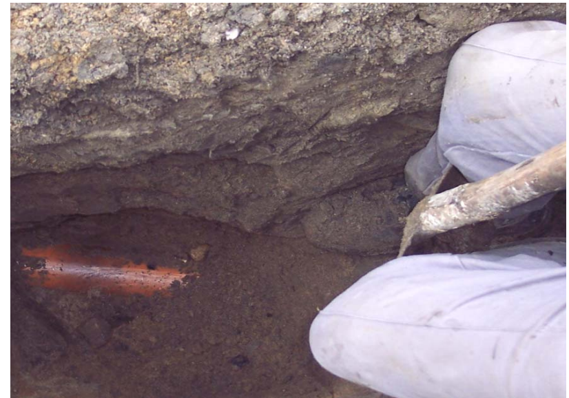
Handelsübliches KG-Rohr als Gasleitung
