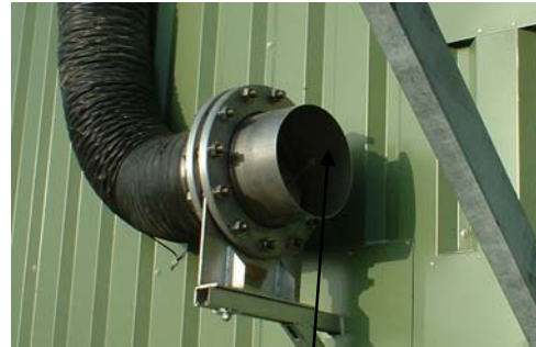
Regelmäßige Abluftmessungen wg. Gasdichtigkeit ! Zwischendach
