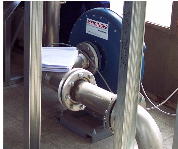
Fachmännisch verbaute Kompensatoren an einem Verdichter (links)
