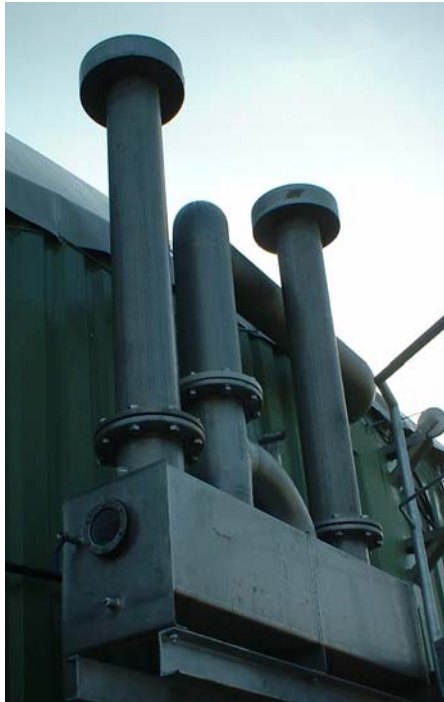
Überdruck-/Unterdrucksicherung am Fermenter
